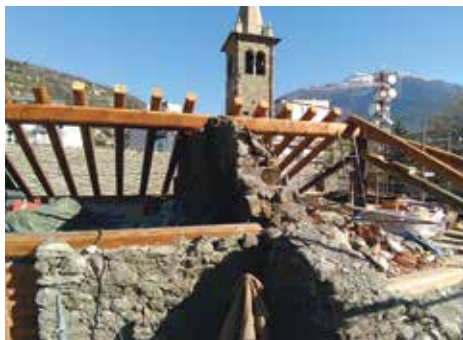
Durante i lavori
