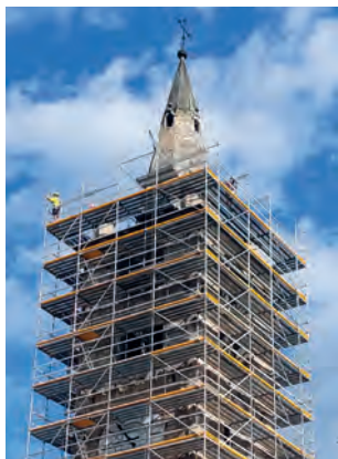
Fasi di smontaggio del ponteggio
